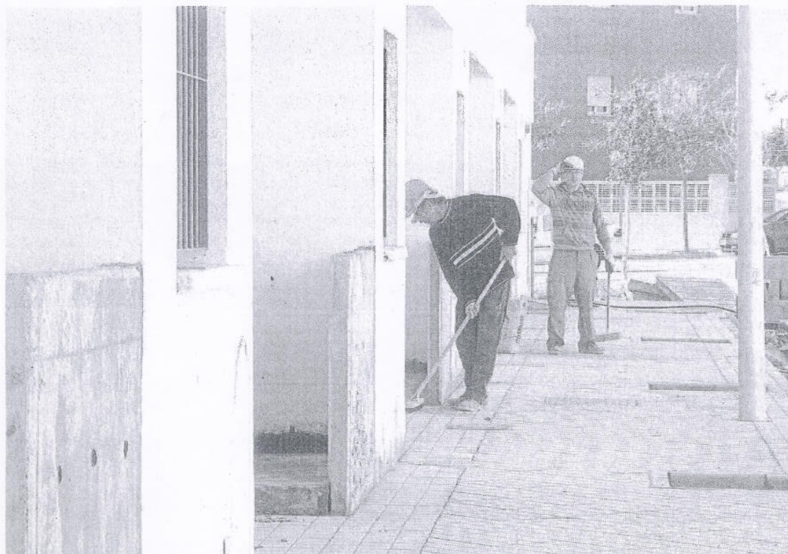
Dos obreros dan los últimos retoques a una nueva promoción de viviendas.
