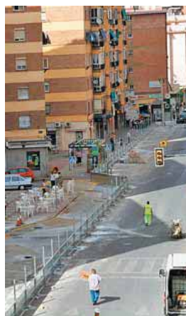
En calle La Unión terminan los muros.
